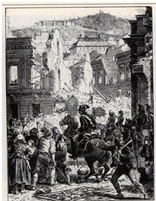
Démolitions place de Bellecour.
